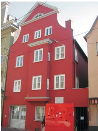
Das renovierte Mozarthaus in der Frauentorstraße
